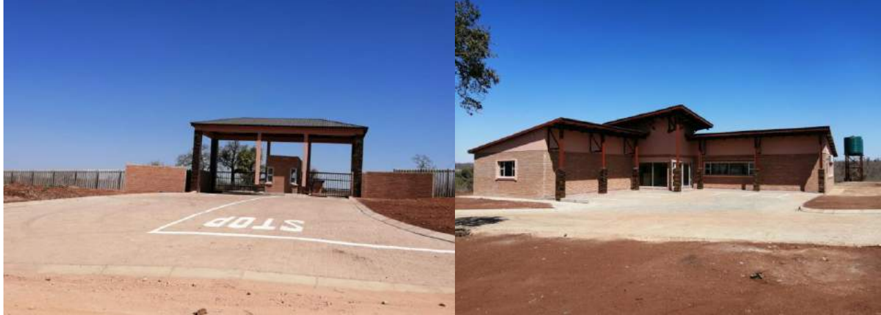
Figure 5.9.: Land Fill Site
